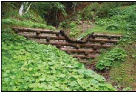
Briglia in legname e pietrame con conseguente rottura del profilo longitudinale naturale (livello di base intermedio (livello di base locale)); lungo il versante sx della Val Uqua (Catena Carnica, Alpi Carniche); 26 Luglio 2014.
