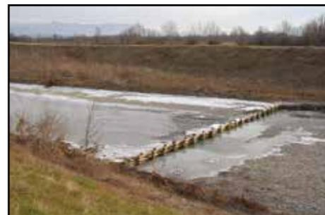
Soglia artificiale in legname con conseguente rottura del profilo longitudinale naturale (livello di base intermedio (livello di base locale)); dalla sponda dx del Torrente Versa, pressi di Mariano del Friuli (Pianura Friulana); 6 Gennaio 2009. (Foto R. Ferrari)
