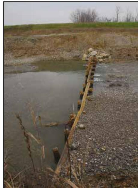
Soglia artificiale in legname con conseguente rottura del profilo longitudinale naturale (livello di base intermedio (livello di base locale)) (verso della corrente da dx a sx; molto evidente il deposito di materiali a monte dell'opera e l'erosione a valle della stessa); dalla sponda sx del Torrente Versa nel tratto Mariano del Friuli - strada Capriva del Friuli-Cormòns; 17 Gennaio 2010. (Foto R. Ferrari)
